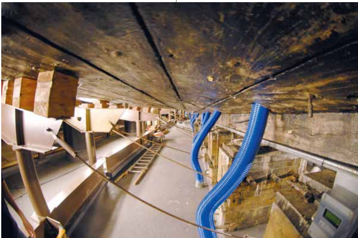
Belastningen på stöttorna varierar över fartyget. Träkilarna mellan sidostöttorna och skeppet justeras då och då för att "rätt" tryck skall erhållas. De blå slangarna tillhör klimatanläggningen som ser till att riksklenoden håller rätt temperatur och fuktighet.
