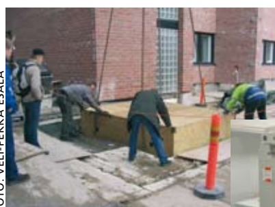
Koordinatmätmaskinen från Mitutoyo firades ner på plats i laboratoriet genom ett hål i marken.
